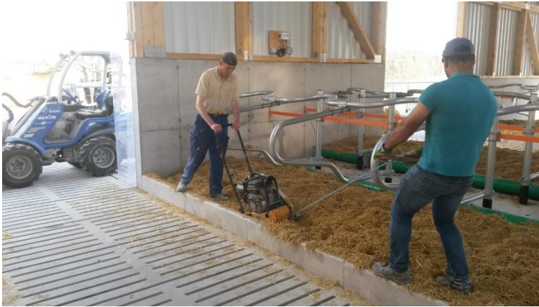
Abbildung 2: Verdichten der Kalk-Stroh- Deckschicht
