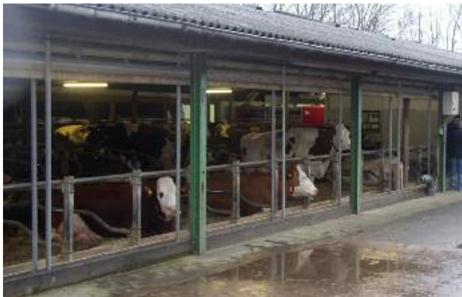
Bei diesem älteren Stall wurde die Außenwand komplett geöffnet. Die Kühe lieben es!
