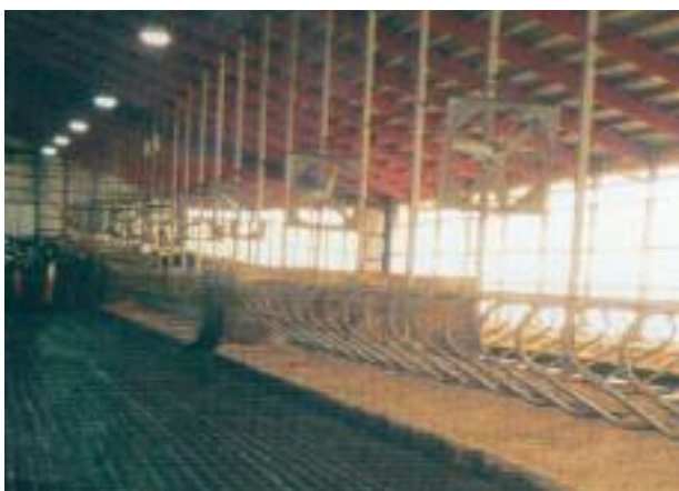
Ventilatoren in Reihe über den Mittelboxen sorgen für einen guten Luftwechsel und Luftbewegung.
