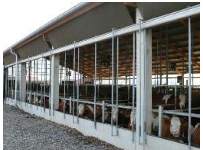
Hoher Stall mit isolierter Decke, stärkerer Dachneigung und Ventilatoren für einen guten Luftaustausch.
